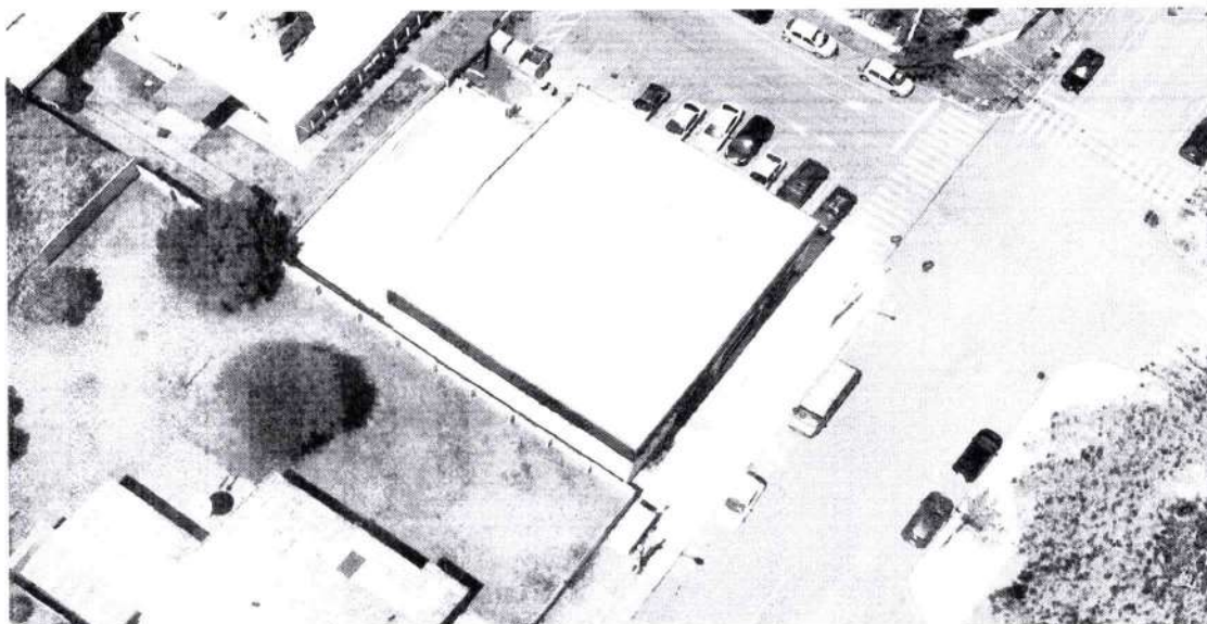
Figura1: Localização aérea do Imóvel Barracão Comercial.
